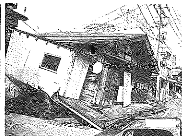
小千谷 崩壊家屋
