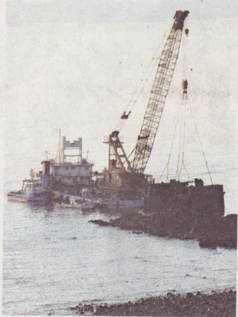
クレーン船で引き上げられる、 切断された台船
