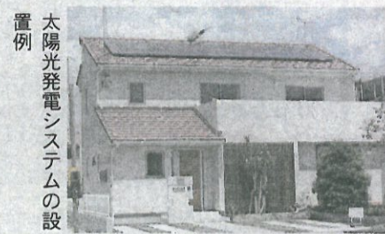
太陽光発電システムの設置例
