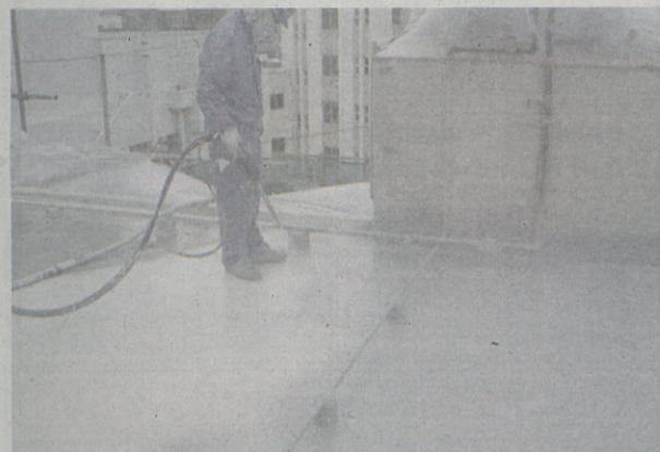
ジェットスプレー工法でコーティングを施している様子。吹き付けている「呼吸性ウレタン」は、防火層が下地全面と完全密着して防水性を高め、躯体強化の効果も
